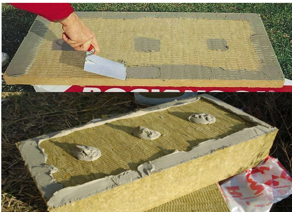
Obr. 4: Nanášení lepicí hmoty pomocí obvodového pásku
