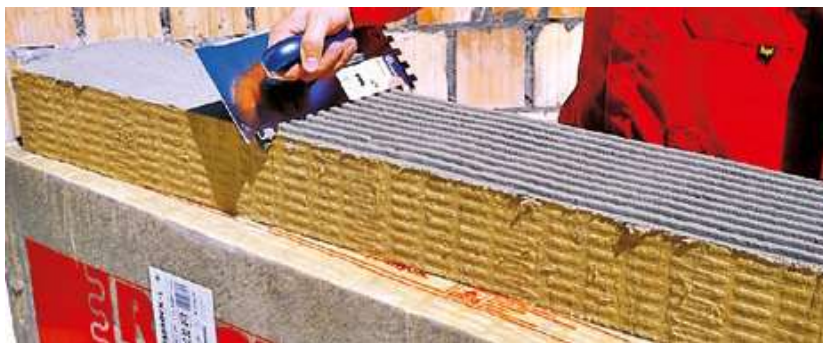
Obr. 5: Celoplošné nanášení lepicí hmoty
